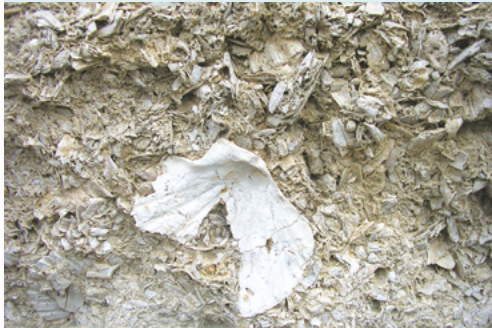
Fragments de coquillages et d'une coquille Saint-Jacques dans les pierres de construction des piliers de l'aqueduc (allée basse du Peyrou), provenant des carrières de Pignan et de Saint Jean de Védas.
